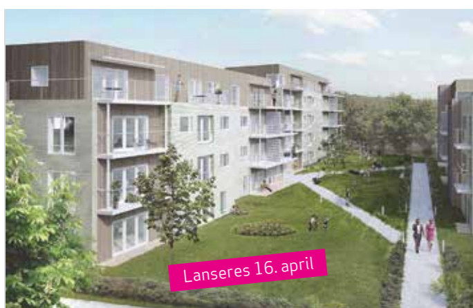
Rybergsvingen Borettslag - 50 leiligheter i Ing. Rybergsgt. 2-3-4 roms osv.
