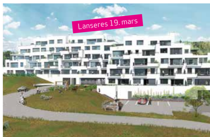
Granittlia Terrasse Borettslag - 40 nye terrasseleiligheter rett ved Solbergelva.
