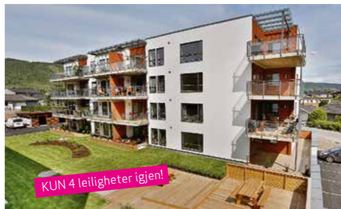
Fremtiden Borettslag - Sentralt og idyllisk, Åssiden. Kun fire leiligheter igjen. Priser fra kr 4.015.000,-
